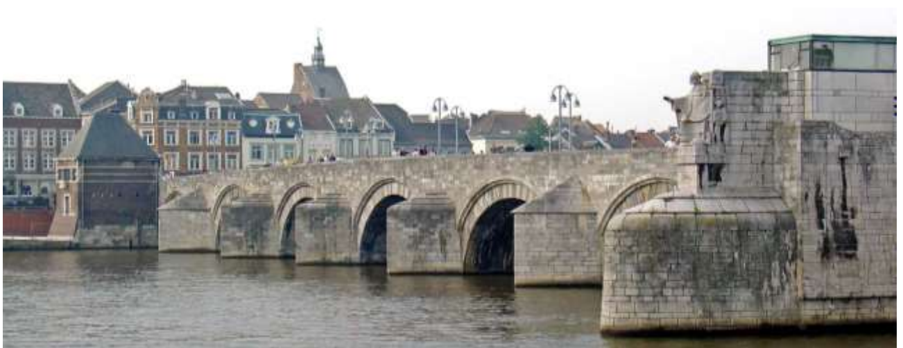
Brug over de Maas.
